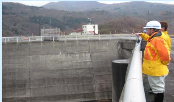
11/17 寒河江ダム 現場視察
