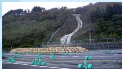
11/5新庄国道維持、現場視察
