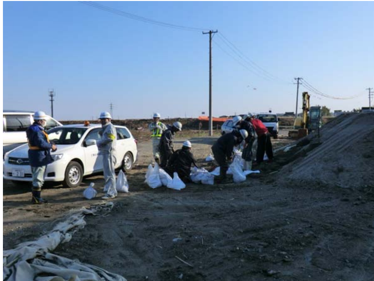
国道 6 号 土のう製作状況
