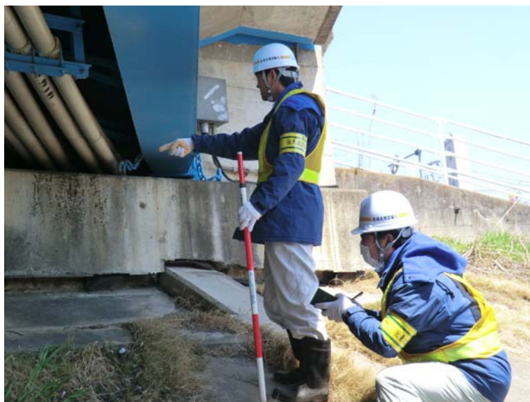
国道6号 橋梁点検状況
