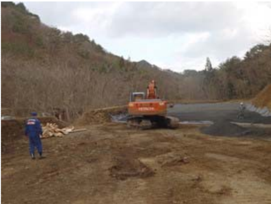
埋葬予定地造成作業状況 (4/2)
