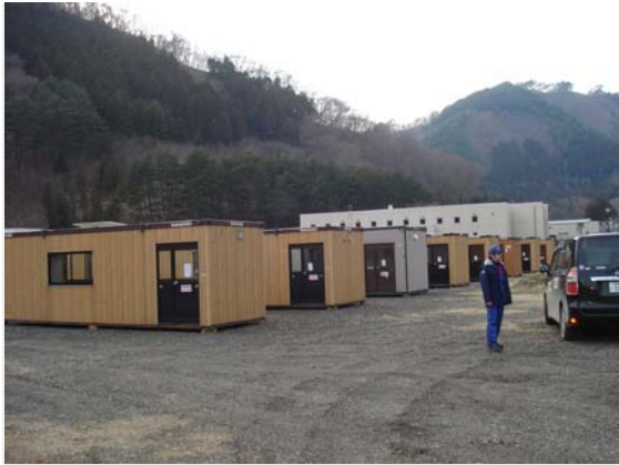
仮設ハウス搬入確認 (3/29)
