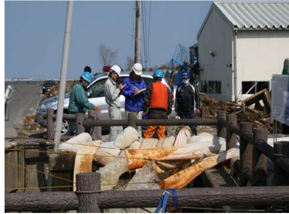
排水作業現場打合せ状況（4/22）
