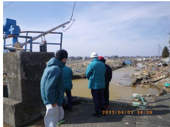
浸水箇所現地調査状況 (4/1)
