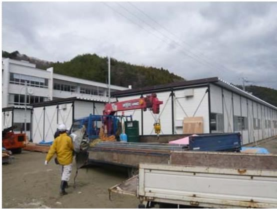
仮設住宅建設状況確認 (4/20)
