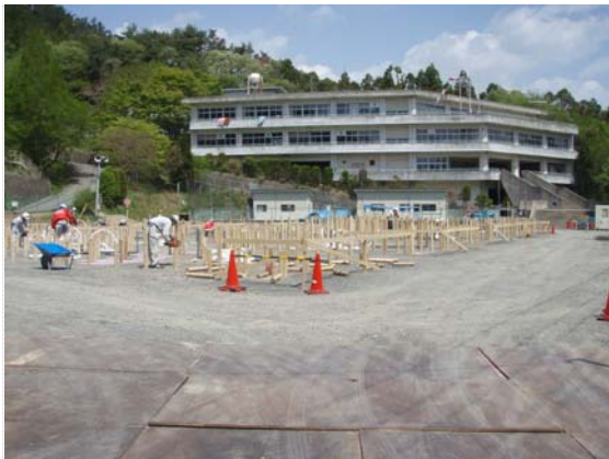
仮設住宅建設進捗状況確認 (5/14)
