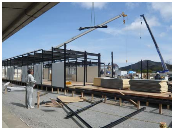
仮設住宅建設進捗状況確認 (5/2)
