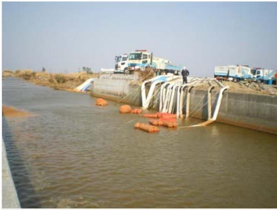
排水状況確認 (4/13)
