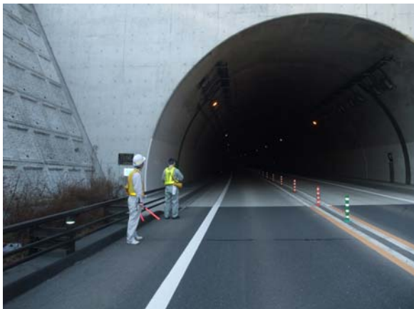
鵜波トンネル南側坑口
