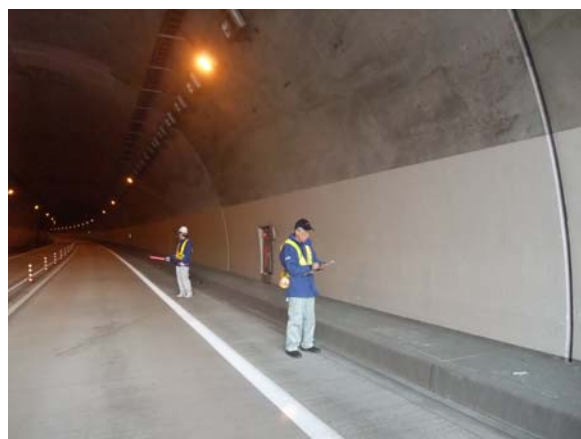
鵜波トンネル内状況確認
