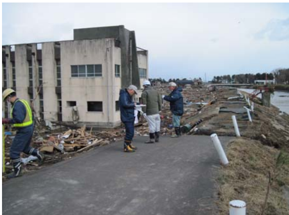
貞山堀 藤曾根排水機場(岩沼市) 調査状況
