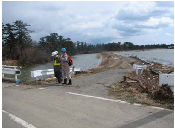
貞山堀寺崎橋付近(岩沼市) 調査状況
