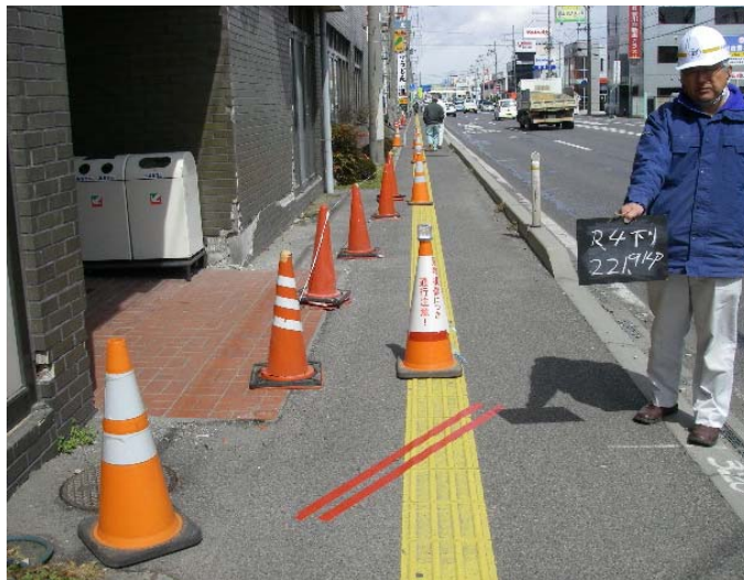
国道4号 221.9KP 下り線 郡山市川向地内 ビルのタイル落下の恐れ
