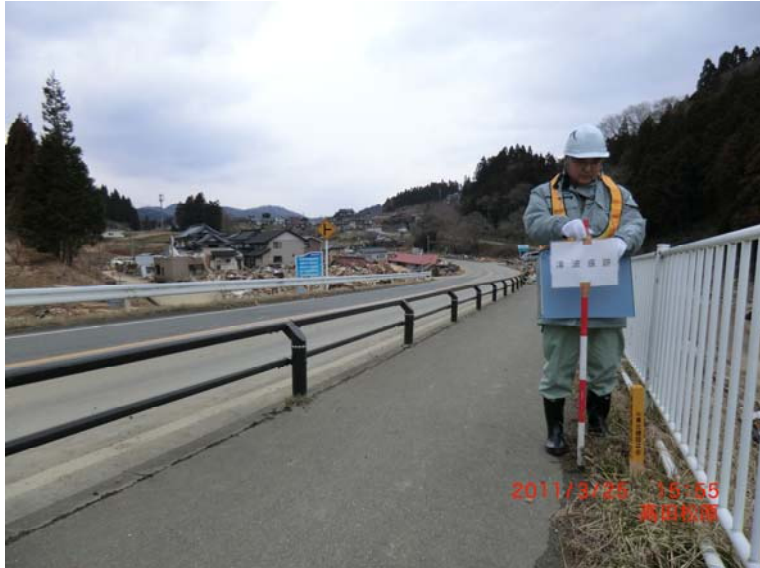
陸前高田市 作業状況
