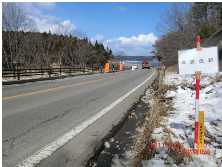
普代村 作業状況
