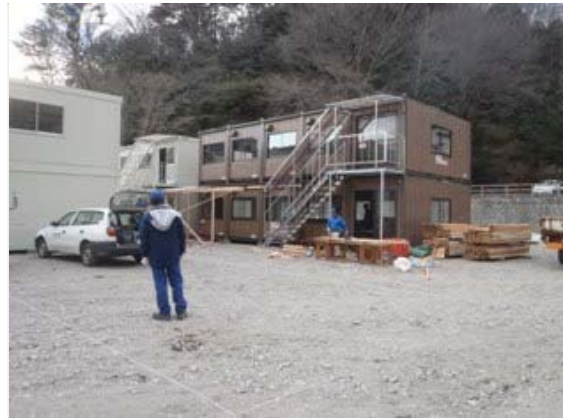
仮調査設置作業状況 (4/3)
