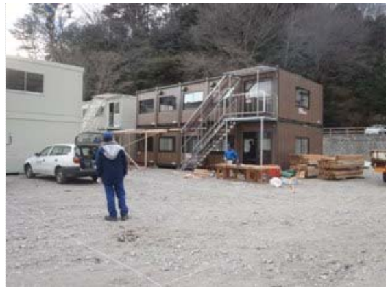
仮調査設置作業状況 (4/3)
