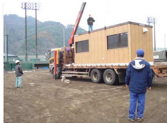
仮設ハウス搬入状況 (3/30)
