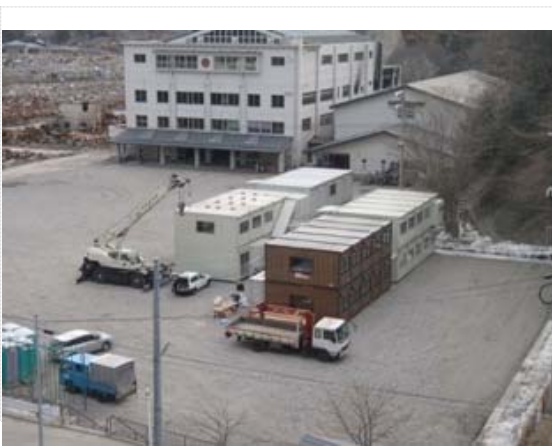
仮調査設置作業終了 (4/3)
