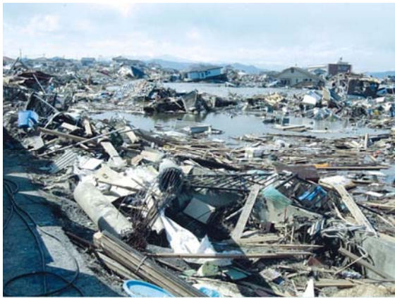
荒浜地区被災状況 (3/24)
