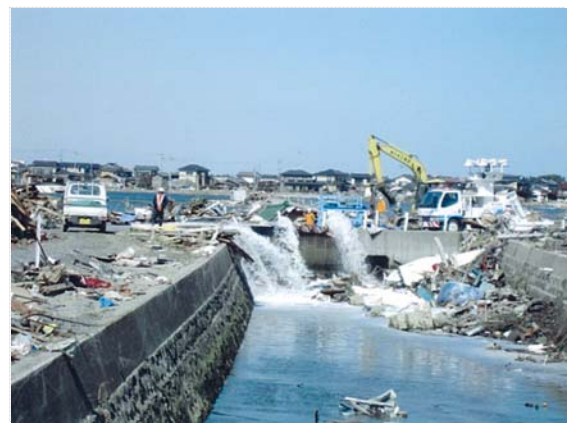
荒浜地区排水状況 (3/24)
