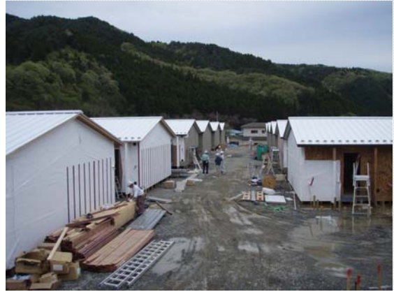
仮設住宅建設進捗状況確認 (5/10)
