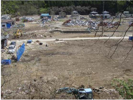
がれき撤去状況 (5/9)
