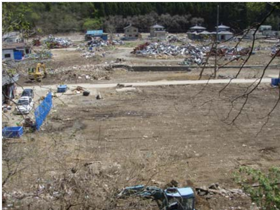
がれき撤去状況 (5/9)
