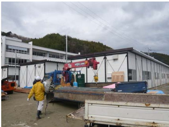
仮設住宅建設状況確認 (4/20)
