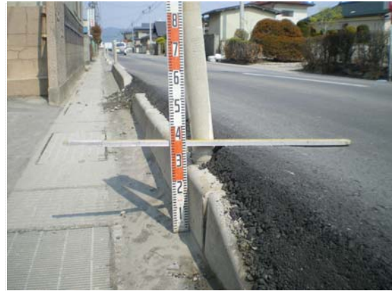
R398 嵩上げ状況 (5/17)
