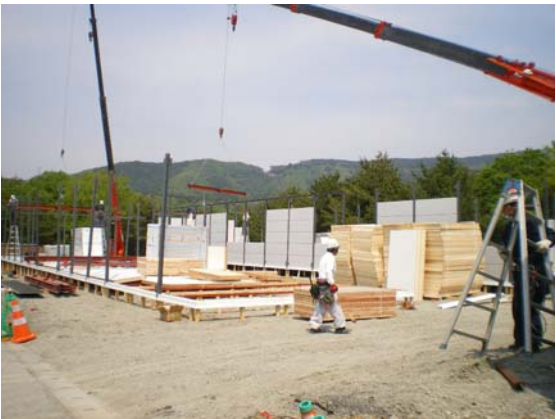
仮設住宅建設進捗状況確認 (5/17)
