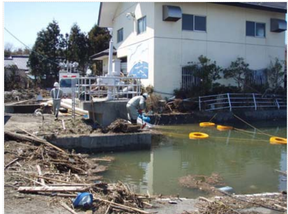
ポンプ設置確認 (4/5)
