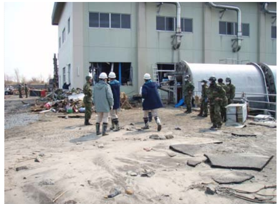
排水ポンプ設置箇所現地確認 (3/30)
