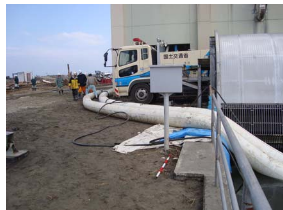
排水ポンプ設置箇所ヤード造成 ポンプ車設置立会い状況 (3/31)
