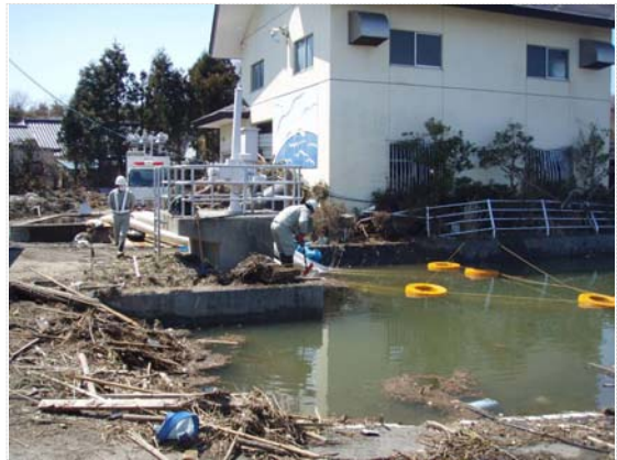
ポンプ設置確認 (4/5)
