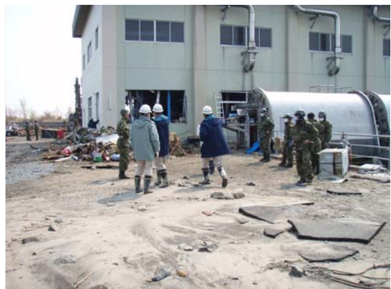
排水ポンプ設置箇所現地確認 (3/30)
